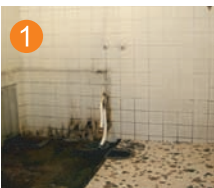
1 浴槽、水栓等設備器具の取り外し
