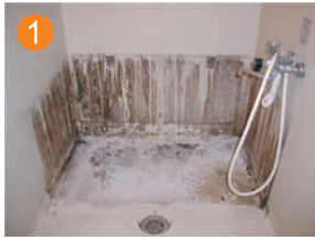
1 下地処理、清掃・部分パテ
